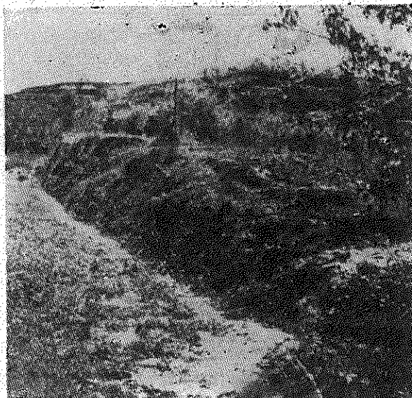
图一〇 临洮县尧甸长城坡红土地秦长城遗迹
